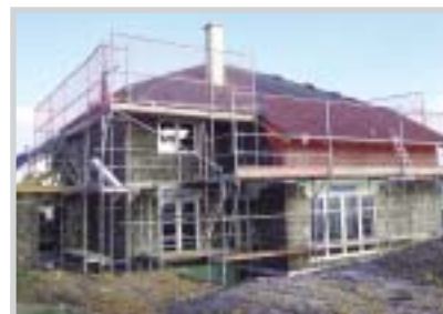
Bei Neubauten prüft der Schornsteinfeger die ordnungsgemäße Installation.
